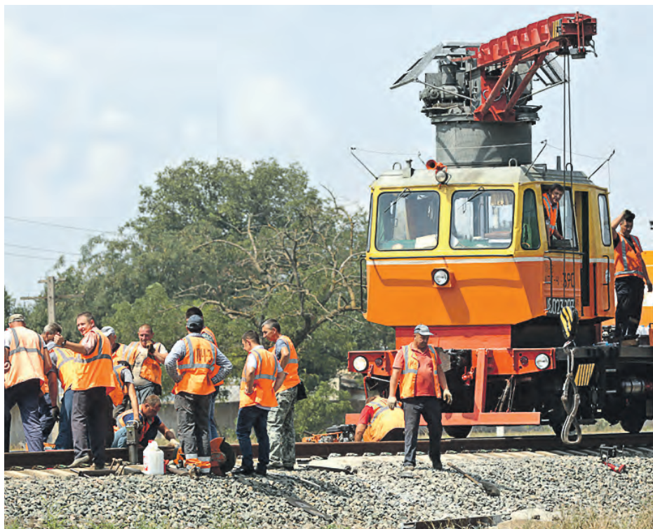
16 августа 2022 года. Ремонтная бригада восстанавливает железнодорожные пути возле села Азовское, поврежденные из-за детонации боеприпасов в селе Майское
