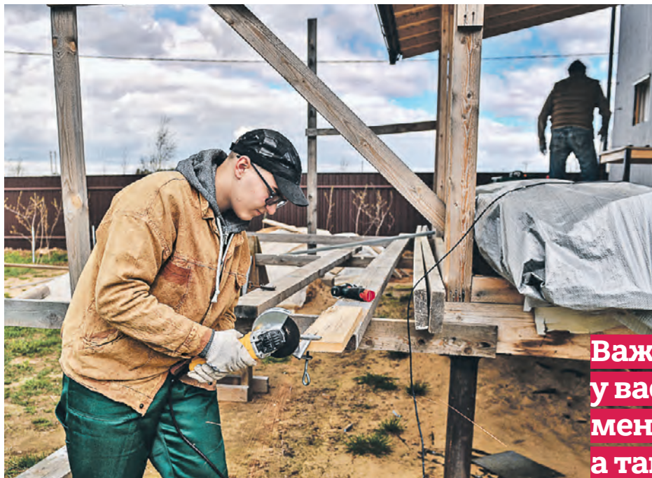
Владелец дачного участка в деревне Маврино Щелковского района Московской области занимается строительством дома
