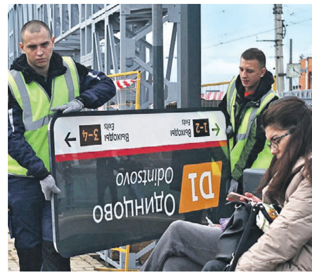
24 октября 2019 года. Установка элемента навигации МЦД на станции Одинцово
