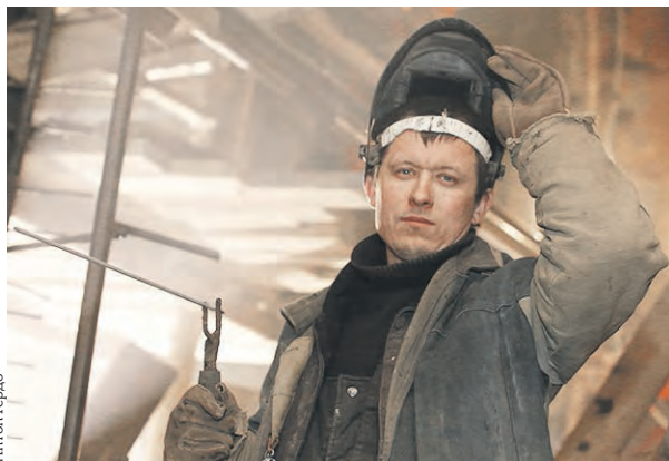
12 марта 2018 года. Сварщик Иван Бобров заканчивает свой этап работы на станции «Нижняя Масловка»
