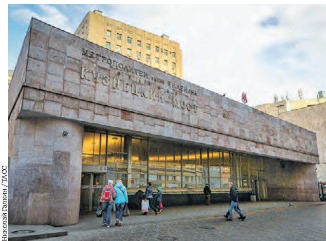
19 апреля 2015 года. Фасад вестибюля станции «Кузнецкий Мост» Таганско-Краснопресненской линии
