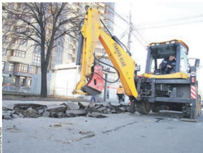
Вчера 12:07 Рабочий-экскаваторщик собирает куски старого асфальта, чтобы затем отправить их на переработку
