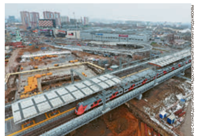
Строительство транспортно-пересадочного узла «Рязанская»
