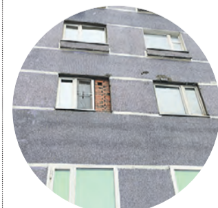
29 января 2015 года. Фасад дома № 38 по Марксистской улице
