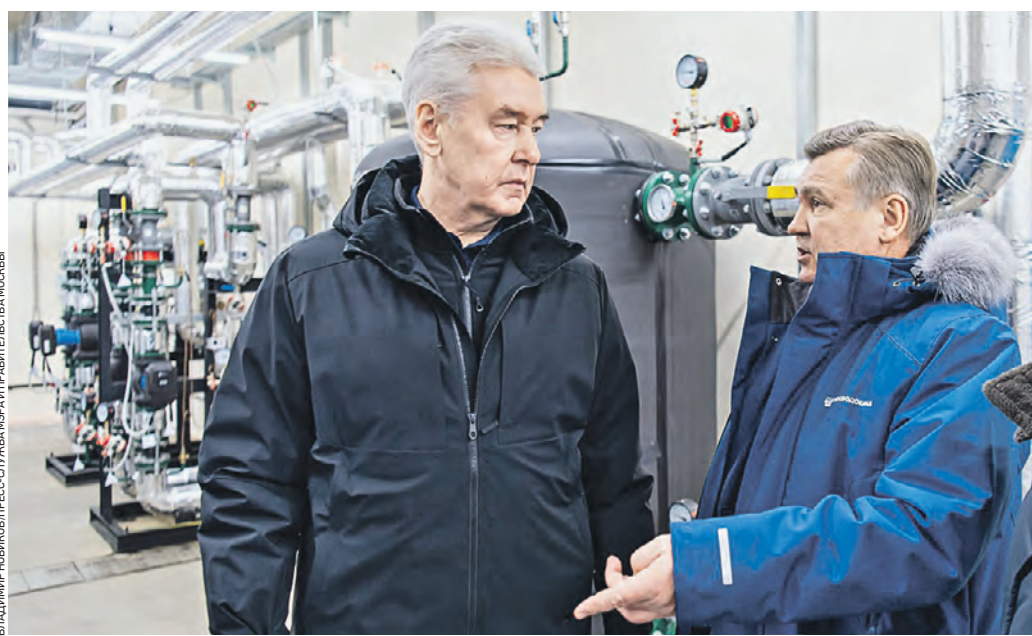
7 декабря. Мэр Москвы Сергей Собянин (слева) и гендиректор Мосводоканала Александр Пономаренко осматривают Люберецкие очистные сооружения
