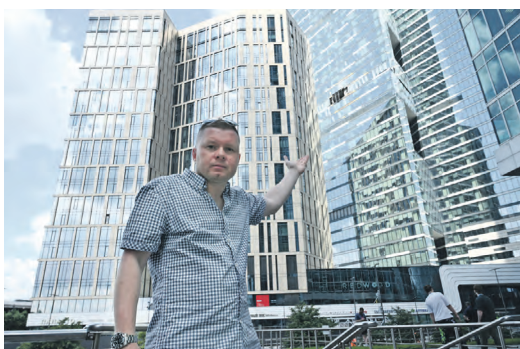
Вчера 11:09 Житель столицы Олег Барханов показывает на поврежденный фасад здания в деловом центре «Москва-Сити», куда попал беспилотник
