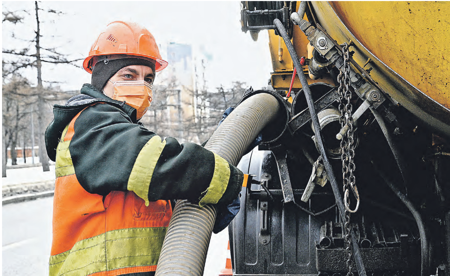
18 февраля 13:37 Специалист ГУП «Мосводосток» Александр Гуров готовит спецтехнику к очистке водоприемного колодца: сначала его прочистят водой под давлением, а затем откачают воду и ил с помощью специального насоса
