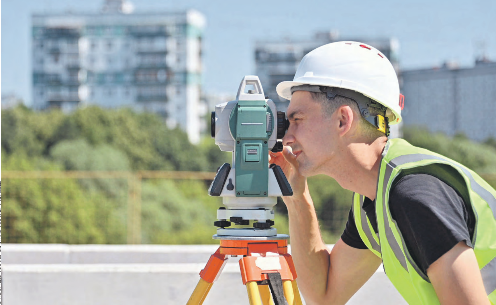
Вчера 16:29 Ведущий инженер-геодезист строительной компании Александр Носов с помощью специального прибора составляет карту местности и проводит расчеты, необходимые для описания рельефа на участке строительства магистрали между улицей Маршала Шестопалова и путями Павелецкого направления железной дороги
