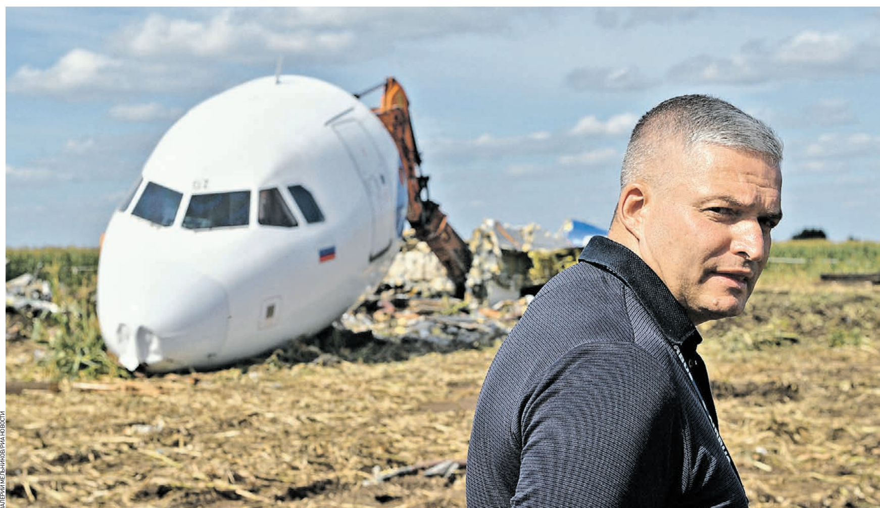
24 августа 13:45 Начальник участка ОАО АК «Уральские Авиалинии» Борис Боржин на поле, где идет демонтаж воздушного судна. Прежде чем разрезать корпус лайнера, рабочие откачали все топливо и гидравлические жидкости и демонтировали внутреннее оборудование
