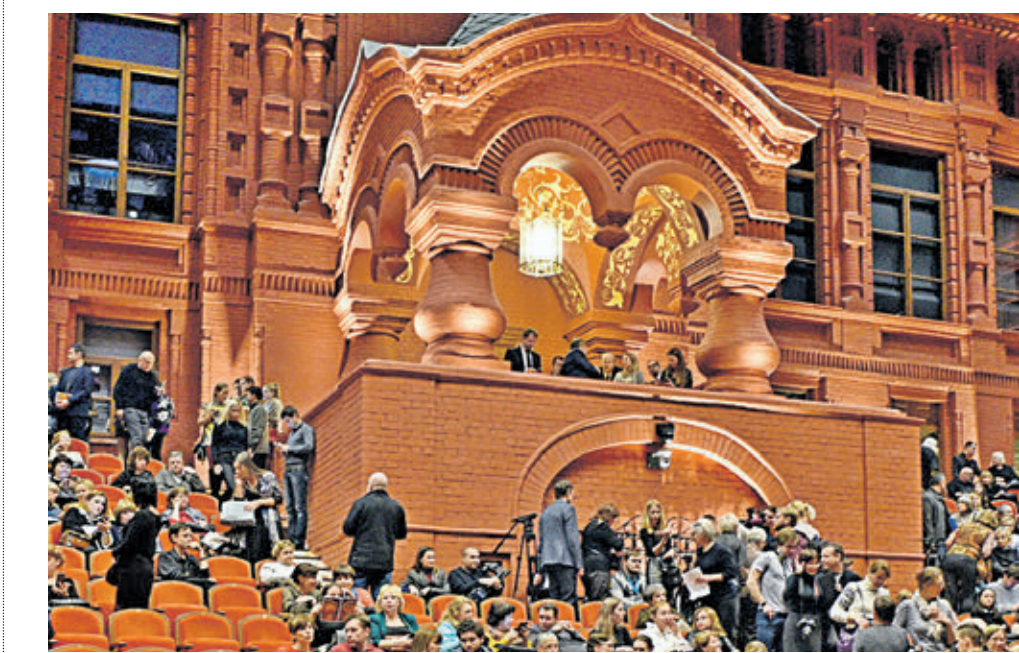
Музыкальный театр «Геликон-опера» на Большой Никитской улице располагается в старинной усадьбе. Коллектив под руководством Дмитрия Бермана до сих пор благодарен за ту работу, которую провели строители по возведению особняка из небытия. Зрители тоже довольны.
