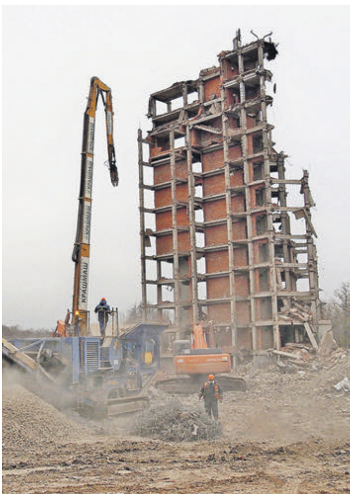
Вчера 10:45 Демонтаж центральной части здания Ховринской больницы. Снос завершат до 25 ноября
