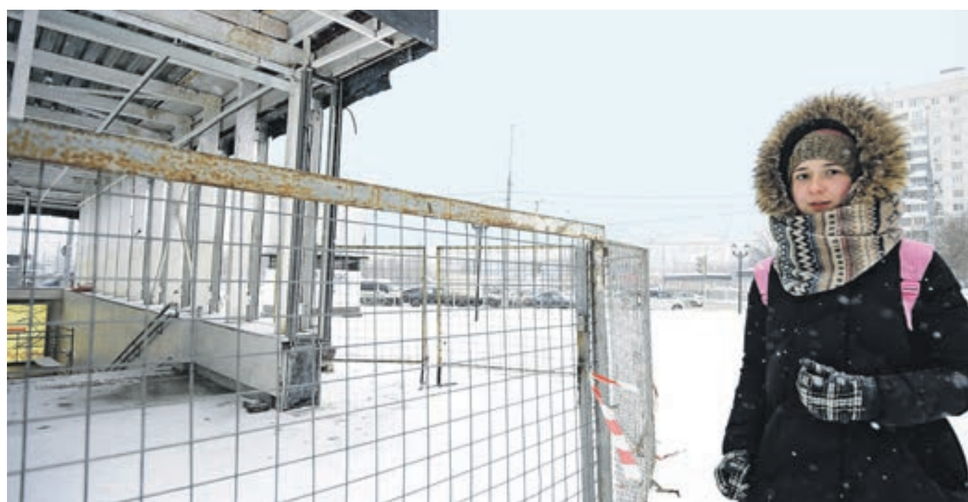
21 декабря 10:13 Студентка Наталья Семенова каждый день с надеждой заглядывает за строительный забор у выхода со станции метро «Южная», так как из-за затянувшегося ремонта ее дорога увеличивается минимум на 10 минут
