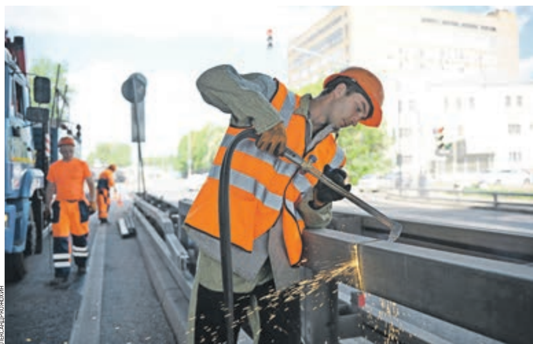
Вчера 12:10 3-я Магистральная улица. Рабочий Владимир Егоров срезает балку поврежденного ограждения. Вместо нее установят новую и приведут в порядок отбойник
