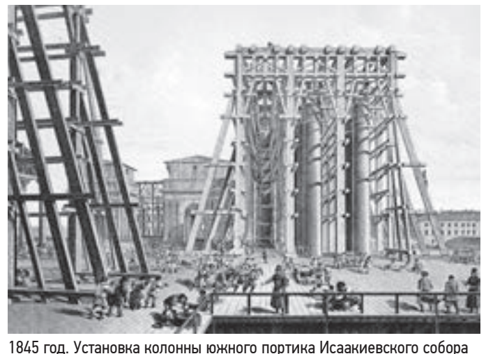
1845 год. Установка колонн южного портала Исаакиевского собора
