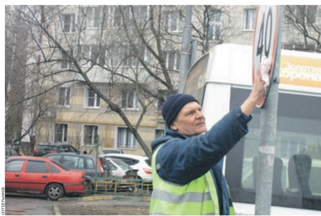
Вчера 10:00 Монтажник Александр Захаров отмывает от граффити и грязи дорожный знак на автобусной площадке в Олонцком проезде
