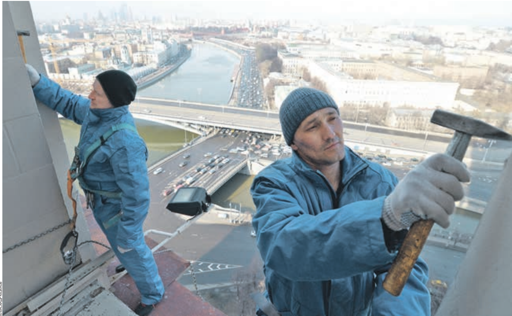
13 марта 2015 года 12:19 Промышленные альпинисты Владимир Королев (справа) и Дмитрий Столяров (слева) проверяют плитку на фасаде высотки на Котельнической набережной. Чтобы выявить плохо закрепленные фрагменты облицовки, мастера аккуратно простукивают камень молотками. Плитку с дефектами оперативно заменяют новой
