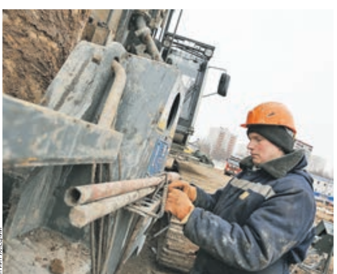
14 февраля 10:37 На строительстве станции метро «Ховрино» задействовано 900 рабочих и специалистов
