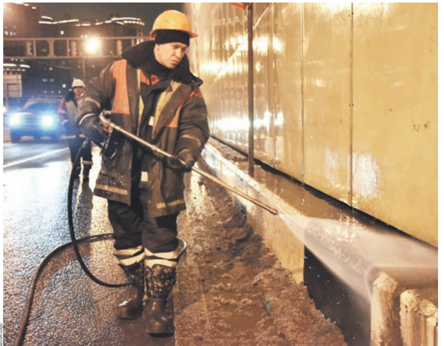
13 февраля 23:10 Сотрудник ГБУ «Гормост» Владимир Фивалей очищает бортовой камень Лефортовского тоннеля моющим пистолетом. В зимнее время промывку тоннелей ведут в любое время суток — главное, чтобы температура воздуха превышала нулевую отметку
