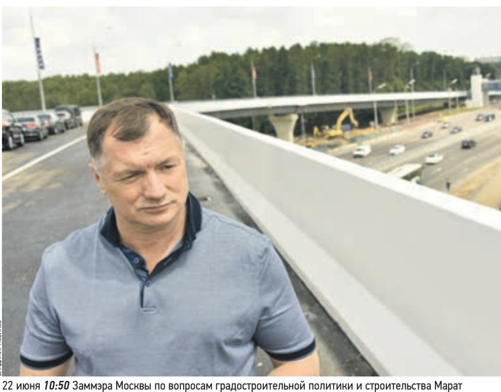
22 июня 10:50 Заммэра Москвы по вопросам градостроительной политики и строительства Марат Хуснуллин осматривает транспортную развязку на пересечении МКАД и Ленинского проспекта
