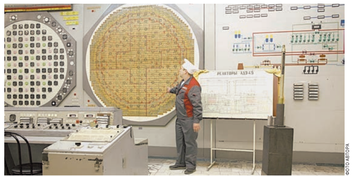
На пульте управления «оружейным» реактором имитирована каждая колонка ТВЭЛов, каждый управляющий графитовый стержень.
