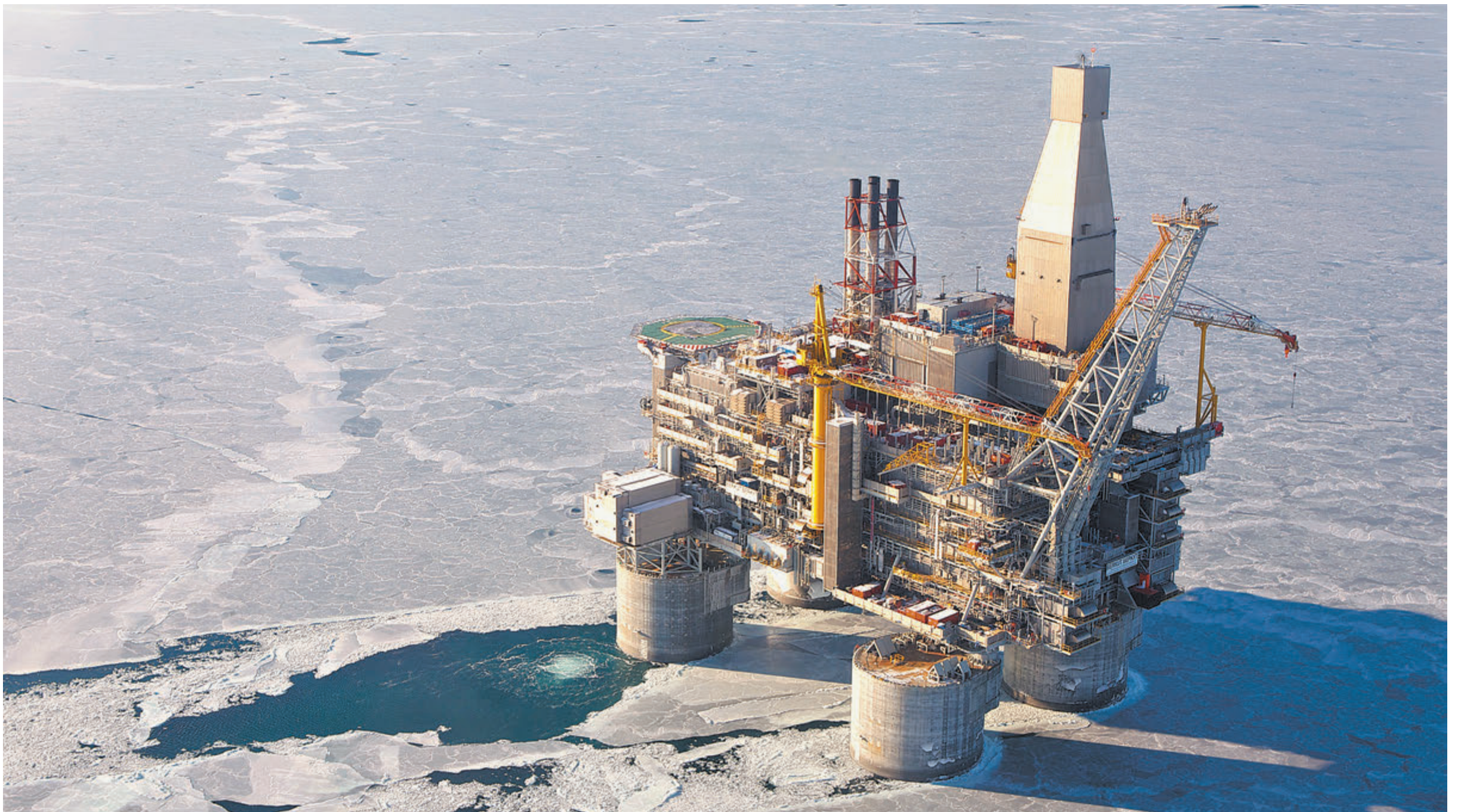
Буровая платформа «Беркут»: вид сверху...
