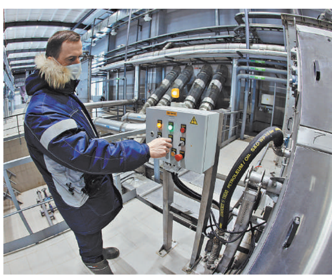
После завершения всех работ столица получит очистные сооружения с повышенной надежностью, которые смогут прослужить более 50 лет.
