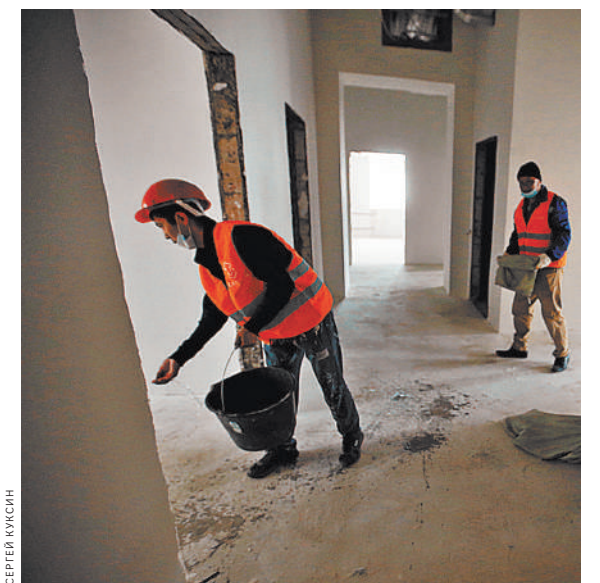
После завершения ремонта будет проведена экспертиза, которая покажет, увеличилась ли энергоэффективность.
