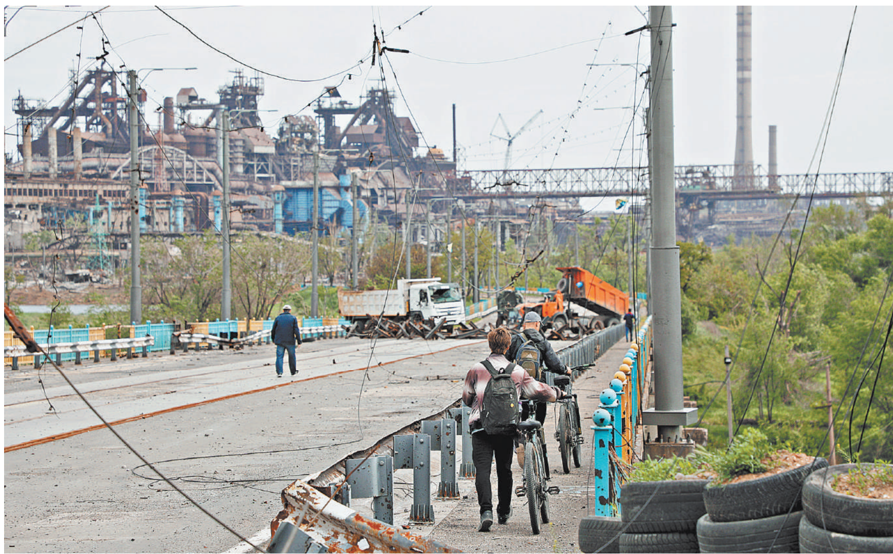
«Азовсталь»: груды бетона, кирпича и металла, смятые машины, разбитые корпуса и цеха, над которыми поднимаются трубы. И никаких признаков жизни.
