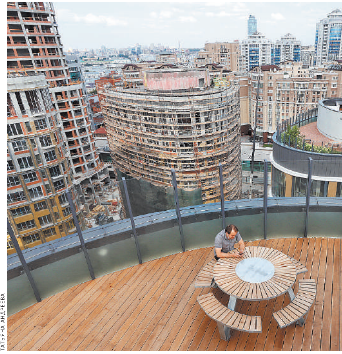
Чтобы небоскребы не превращались в человейники, на их крышах оборудовали бассейны, сады и специальные площадки для отдыха.
