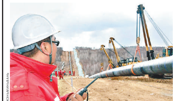
Этот участок восточной ветки российско-китайского трубопровода завершён.
