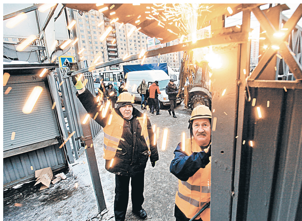
В Петербурге с начала года выдано более двухсот уведомлений на освобождение земельных участков, уже демонтированы павильоны возле станций «Площадь Ленина» и «Проспект Просвещения».
