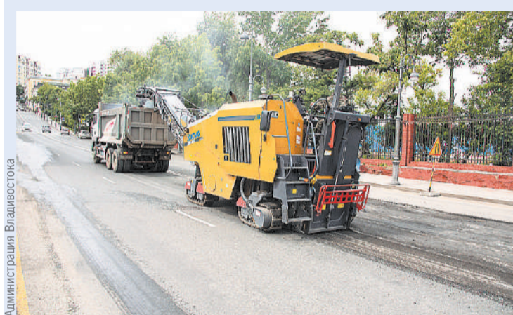
Ремонтники восстанавливают дорогу на Пограничной.
