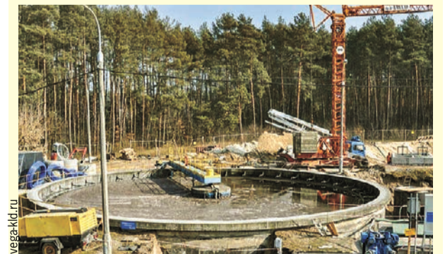
Очистные сооружения построят в Абатском, Вагайском, Омутинском, Сладковском, Упоровском районах и в Ялуторовске.
