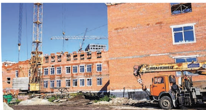
В Тюмени продолжается строительство школы проектной мощностью на 1200 учебных мест в районе ЖК «Звездный городок».
