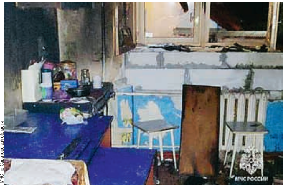
Предварительной причиной пожара стало несоблюдение правил устройства и эксплуатации электрооборудования.
