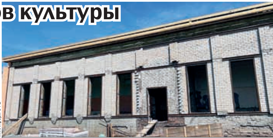
После ремонта в учреждении смонтируют современное оборудование.
