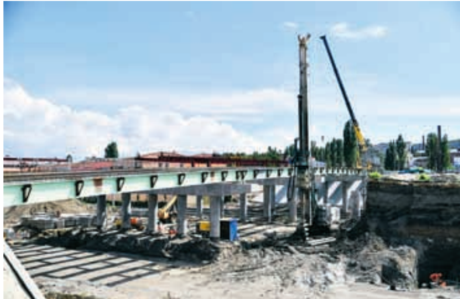
Два года назад был отремонтирован Трофимовский мост. Сегодня идет ремонт путепровода через Глебучев овраг. На очереди мосты на 1-й и 3-й Дачных.
