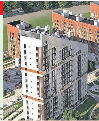
Здания в обоих проектах похожи.
