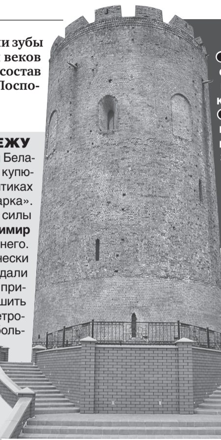
Башня считалась неприступной: ее окружал глубокий ров с водой, а до входа нужно было карабкаться на вал высотой тринадцать метров.
