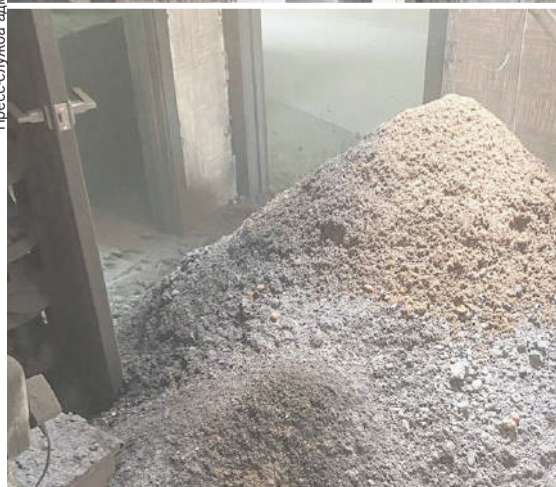
Кровля просто не выдержала тяжести строительных материалов, сложенных в одну кучу.
