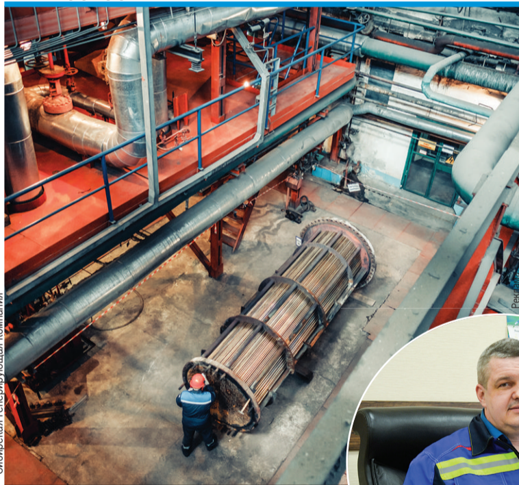
Ремонт дополнительного оборудования Кузнецкой ТЭЦ.
