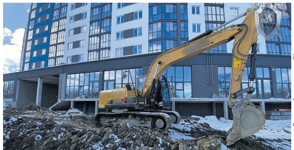
Инцидент произошел при укладке труб.
