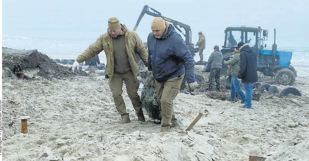
Остатки кафе и променада полностью демонтированы.
