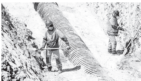
Компания обеспечит микрорайон дорожной и инженерной инфраструктурой.
