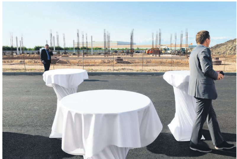
Новые технологии и упрощение процедур в промышленном строительстве должны существенно приблизить сроки сдачи объектов. ФОТО АЛЕКСАНДРА КОРЯКОВА
