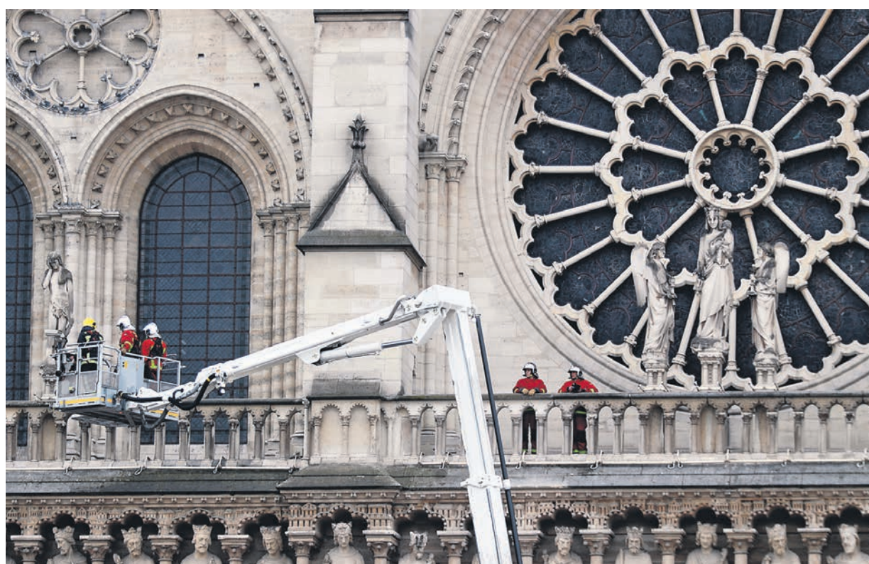
Фасад собора Парижской Богоматери, знаменитые башни и часть уникальных витражей пожарным удалось спасти ФОТО АР
