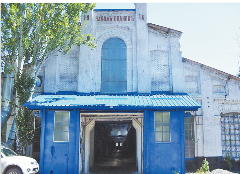
Завод подков построен на территории рудника «Елпидифор» в 1916 году. Здание почти не изменилось, в настоящее время внутри располагается производственный цех. Полы завода подков выстелены деревянными шестигранниками.
