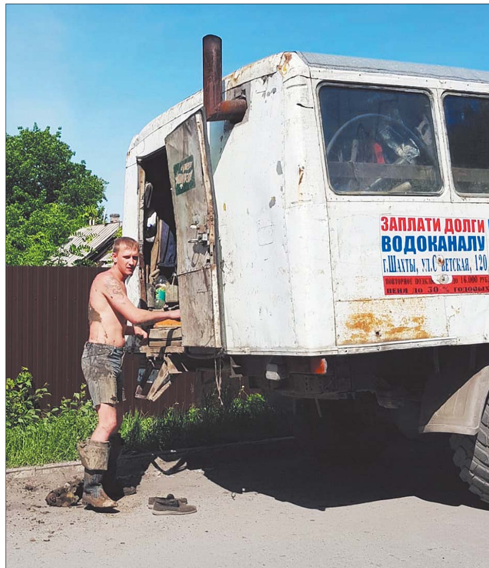
Владимир Гуторов починил водовод жителям посёлка Красина. Фото Анны Левченко.
