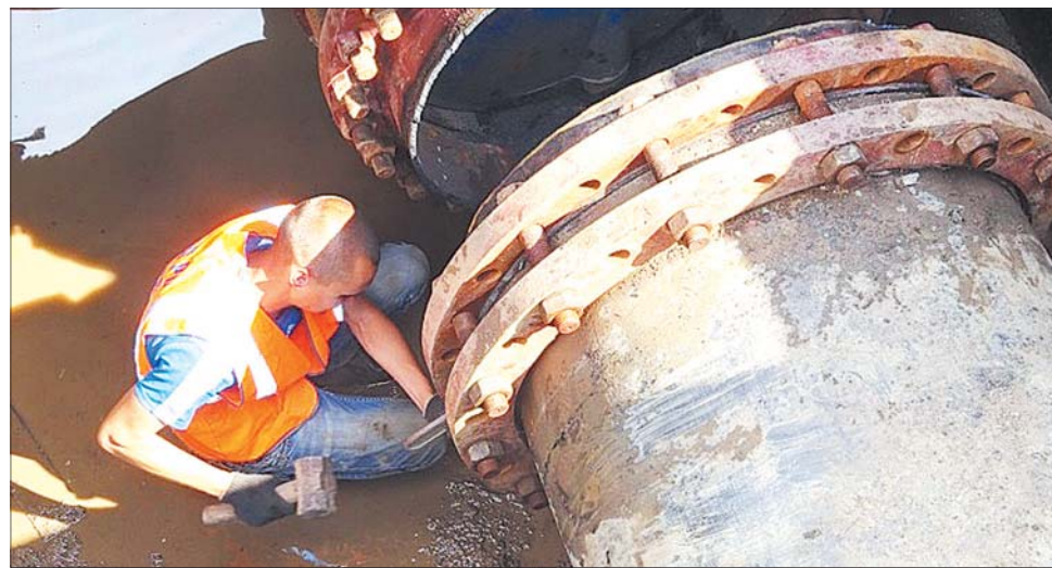
Сейчас на новом участке водовода ведется промывка, опрессовка, дезинфекция.
