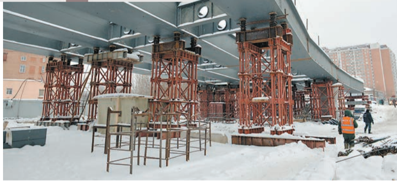
Строительство путепровода через Курское направление МЖД в рамках реконструкции Дорожной улицы.
