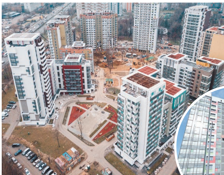
Строительные объекты проверяются сверху донизу - поэтажно и поэтапно.
