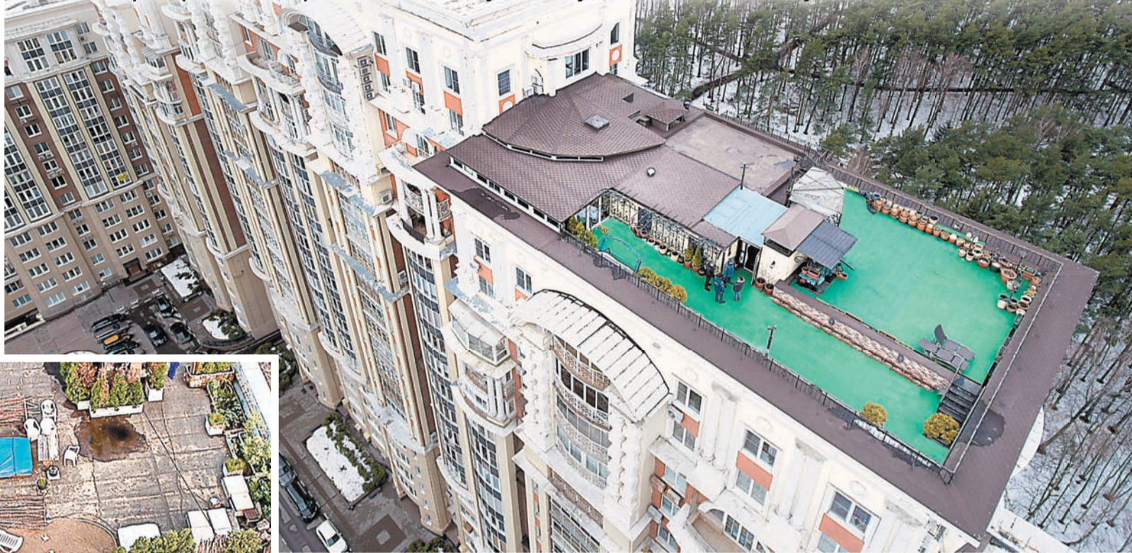
Оригинальная надстройка 20-этажного дома на ул. Маршала Тимошенко, д. 17, корп. 2
